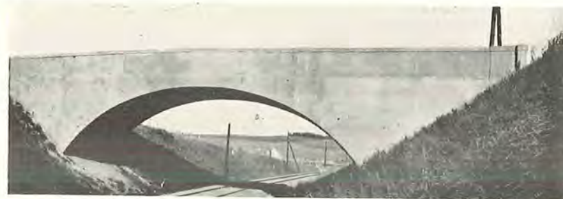
Fig. 56. Den første sprøjtepudsede bro i Danmark udført i 1928.
