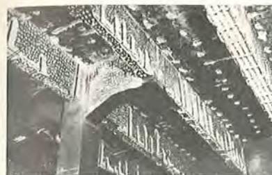
Fig. 47. Parti af en konstruktion under forbehandling. Der er foretaget borthugning af beskadiget beton samt pikhugning af overfladerne, men endnu ikke sandblæsning.
