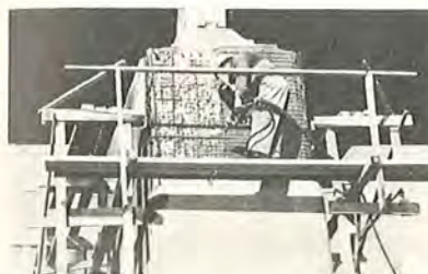
Fig. 49. Figuren til venstre viser øverste del af en af strompillerne på Storstromsbroen efter at afrensning har fundet sted. Den pågældende flade er forsynet med et armeringsnet fastholdt med indstøbte dorne. Påsprøjtning af mørtel påbegyndt.
