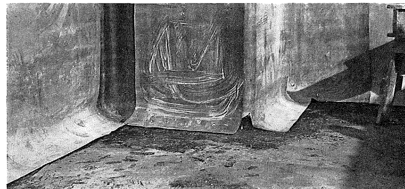
Fig. 122. Isolering af lodrette vægge og hulkebler med termoplastiske plader.
