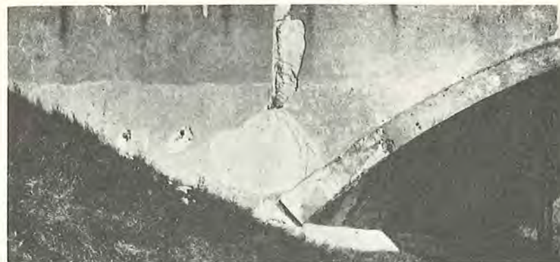
Fig. 12. Vederlagspartiet af en jordfyldt jernbetonbue beskadiget som følge af vandgennemsivning fra jordfylden.
