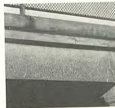
Fig. 27. Svindrevner efter istandsættelse med sprøjtemørtel og injektion.
