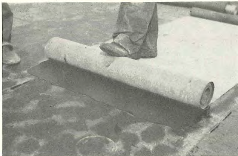
Fig. 96. Udlægning af uldfiltpap ovenpå bitumenplader.
