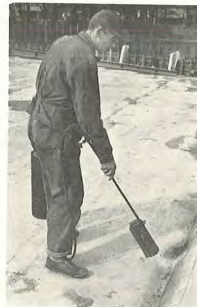
Fig. 86. Afslibning af grater på en betonoverflade ved hjælp af en vandret roterende karborundumskive.
