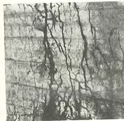
Fig. 29, 30, 31 og 32. Typiske eksempler på map-cracking som følge af skadelige alkalikiselreaktioner i betonen.
