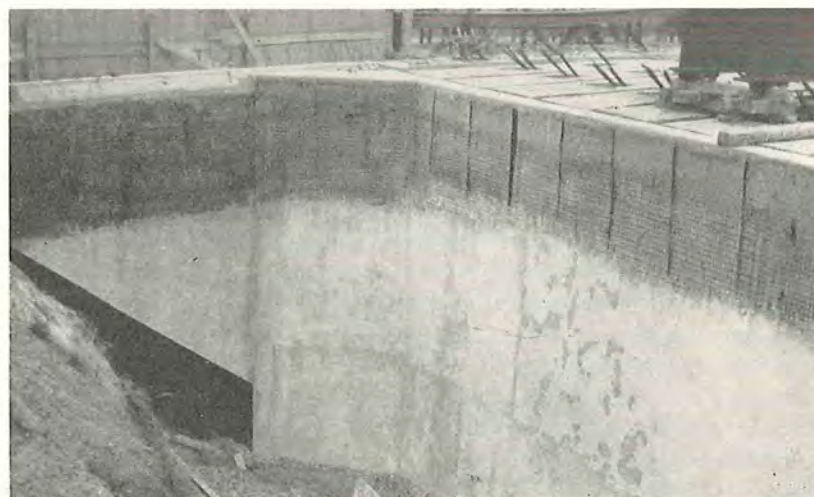
Fig. 94. Udførelse af det armerede puddslag til beskyttelse af den tykke isolation på endepillen af en bro. Det udspændte armeringsnet er ophængt i indstøbte dorne.
