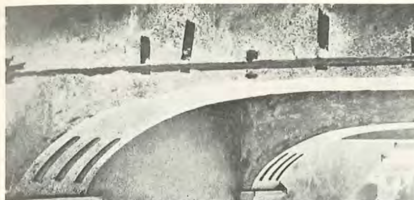
Fig. 2. Typiske afskalninger af betondæklaget uden for armeringen på Tietgensgadeviadukten i København. Sådanne afskalninger finder fortrinsvis sted ved hjørner og er ved ældre konstruktioner meget almindelige. Viadukten er så gammel, at der er anvendt fladjernsbøjler, hvilket utvivlsomt også har bidraget til at fremme afskalningerne.
