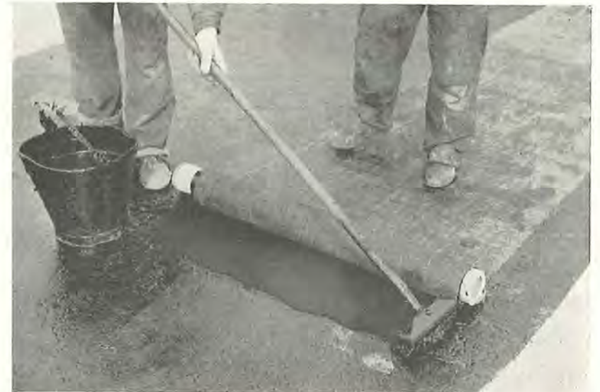
Fig. 90. Påføring af første lag af isolation nr. 3 samt udlægning af imprægneret jute. Man bemærker, at arbejderne benytter bløde sko uden hæle.
