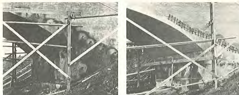
Fig. 62. Istandsættelse ved injektion med cement i revnerne på den i fig. 25 viste bro. Det er vigtigt, at en injektion foregår langsomt, således at der gives det injicerede materiale tid til at trænge så dybt ind i revnesystemet som muligt.
