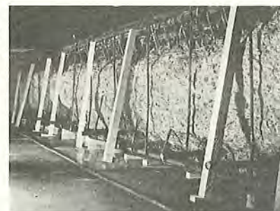
Fig. 69. Samme bro. Forinden forstærkningen foretoges, afhuggedes alt beskadiget beton. Man ser en sådan drager, efter afhugningen, samt supplerende armering anbragt.
