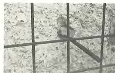
Fig. 49. Figuren til venstre viser øverste del af en af strompillerne på Storstromsbroen efter at afrensning har fundet sted. Den pågældende flade er forsynet med et armeringsnet fastholdt med indstøbte dorne. Påsprøjtning af mørtel påbegyndt.
