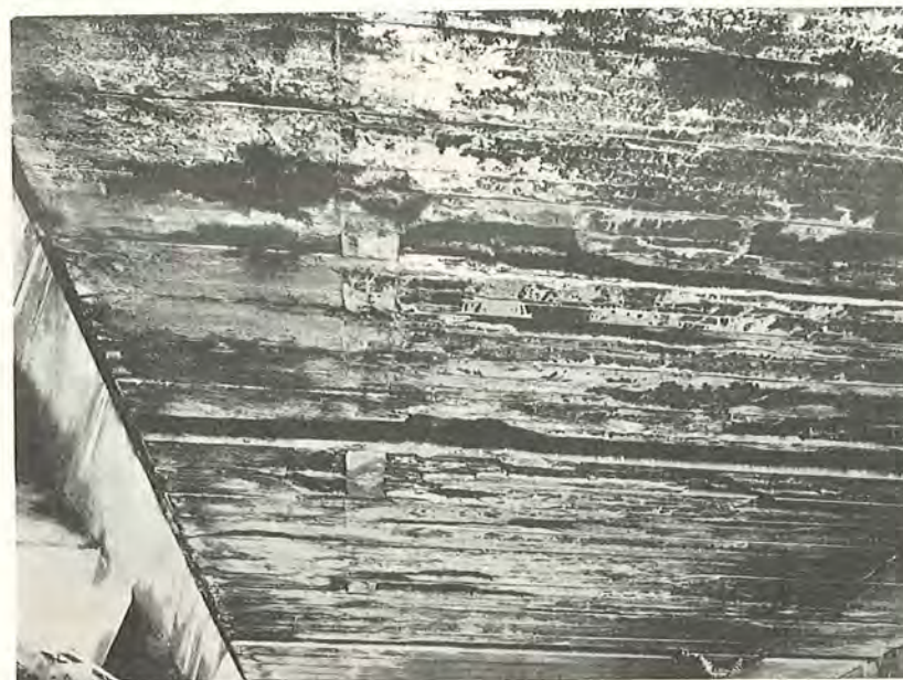
Fig. 21, 22 og 23. Typiske, kraftige betonbeskadigelser på jernbetonkonstruktioner over bybanen i København. Betonens nedbrydning skyldes den særdeles skadelige påvirkning af lokomotivrøg i forbindelse med vandgennemstrømning eller ind sugning af vand.
