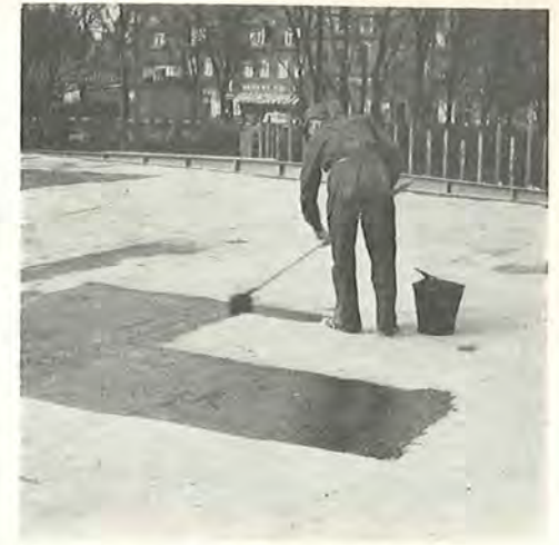
Fig. 88. Afslutning af tyk isolation på en lodret betonflade uden afdækning.
