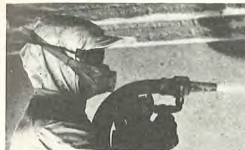
Fig. 54. Sprøjtepudsning af en jernbetonkonstruktion. Dysen holdes i en afstand af ca. 60–80 cm fra den pågældende flade og vinkelret på denne.
