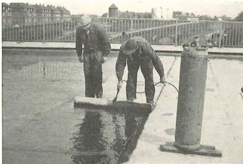
Fig. 97. Udlægning af bitumenplader ved anvendelse af gasflammekaster.
