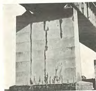
Fig. 27. Svindrevner efter istandsættelse med sprøjtemørtel og injektion.
