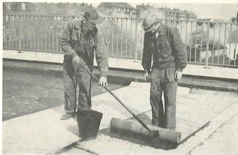
Fig. 98. Udlægning af uldfiltpap ovenpå de i fig. 97 viste bitumenplader.
