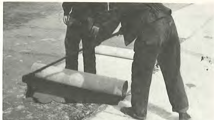
Fig. 95. Udlægning af bitumenplader i klæbemasse på den i forvejen med isolationsmateriale nr. 0 strogne betonoverflade. Arbejderne benytter også her bløde, hæløse sko .
