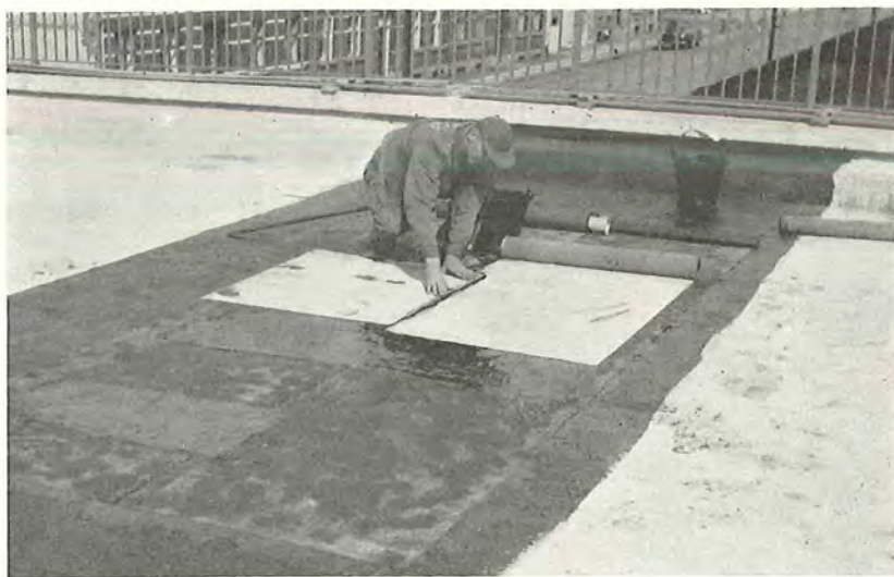
Fig. 92. Figuren viser det påførte isolationsmateriale nr. 0 (grundingsvædske), første lag isolationsmateriale nr. 3, derefter den udlagte imprægnerede jute, hvorpå er påført andet lag af isolationsmateriale nr. 3 samt sluttelig udlægning af det beskyttende lag uldfillpap.
