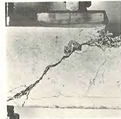
Fig. 37. Forskydningsbrud i prøvebjælke.
