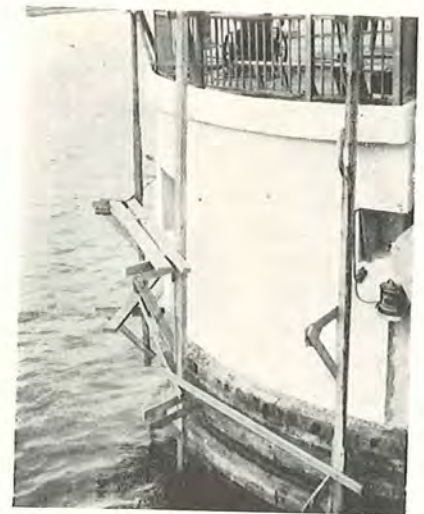
Fig. 72, 73 og 74. Forskellige stadier af samme arbejde som vist på fig. 71.
