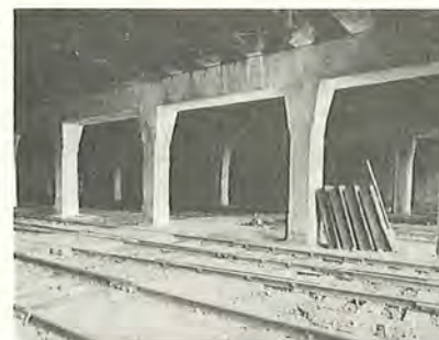
Fig. 70. En mellempille i Østerbrogade-viadukten efter forstærkning og istandsættelse.
