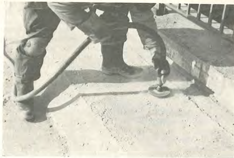
Fig. 86. Afslibning af grater på en betonoverflade ved hjælp af en vandret roterende karborundumskive.
