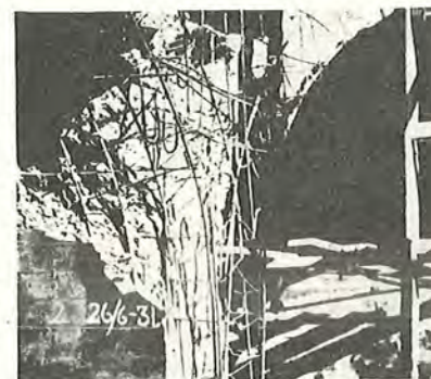
Fig. 12. Vederlagspartiet af en jordfyldt jernbetonbue beskadiget som følge af vandgennemsivning fra jordfylden.
