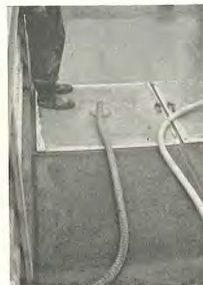
Fig. 112. Vacuumbehandling af betonplader. Nederst et skematisk tværsnit af en vacuum-matte.
