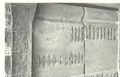
Fig. 47. Parti af en konstruktion under forbehandling. Der er foretaget borthugning af beskadiget beton samt pikhugning af overfladerne, men endnu ikke sandblæsning.
