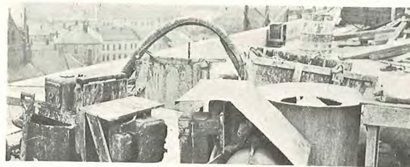
Fig. 82. En noget andet udformning af Colcrete-materiellet. Det ses af figuren, at blande-maskinen kun indeholder én beholder, hvori blandingen af mortelen ved hjælp af en indbygget centrifugalpumpe foregår således, at man først sammenpisker cement og vand og derefter tilsætter sandet. På billedet ses endvidere en Monopumpe (jfr. fig. 81).
