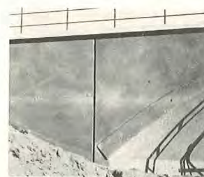
Fig. 57. Et sprøjtepudset felt af Tietgensgade-viadukten.
